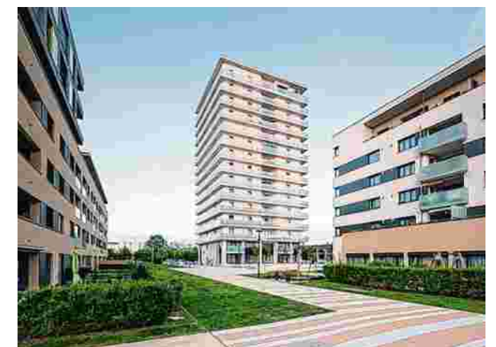
Wohnturm Lange Allee im Süden von Linz (Neue Heimat)
