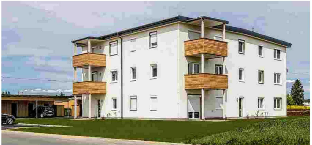
Zwölf neue Baurechts-Eigentumswohnungen wurden in St. Florian/Inn an Investoren und Mieter übergeben.
